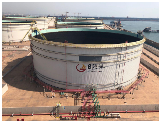
图 6: G 油品公司原油储罐
